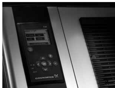
Slika 24 Grundfos CUE kontrolna ploča
